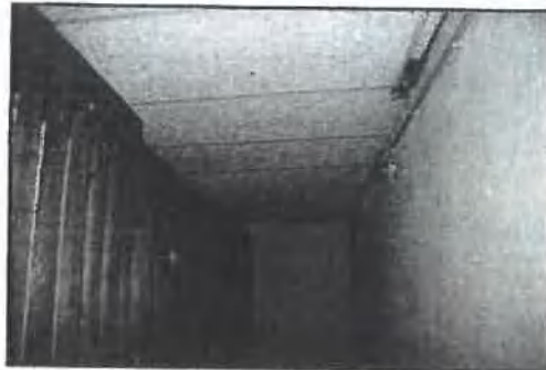
Foto Nr.: 44 – Kellerabteile Holzkonstruktion
