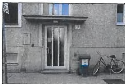
Foto Nr.: 29 - Eingangsbereich
