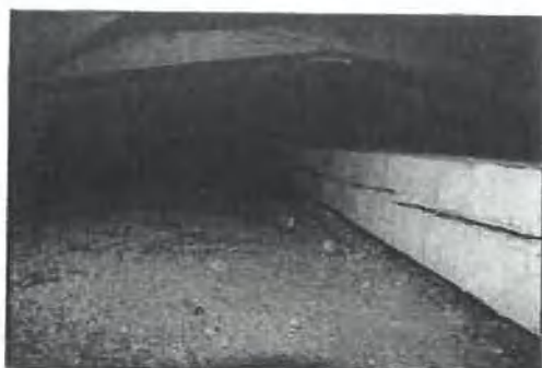
Foto Nr.: 27 – Holzdachstuhl Giebelbereich
