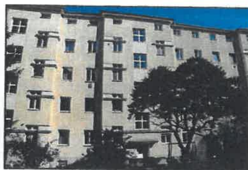
Foto Nr.: 8– Hofseite Nord
