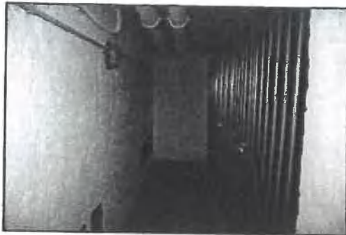
Foto Nr.: 43 – Kellerabteile Metallkonstruktion
