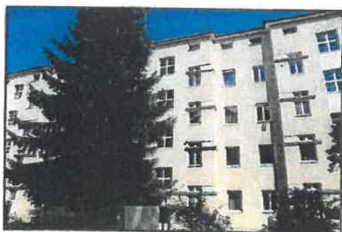
Foto Nr.: 9– Hofseite Nord
