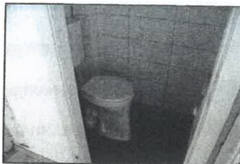
Foto Nr.: 52 – Sanitäreinrichtung WC
