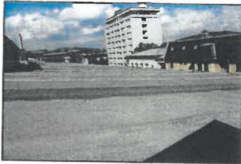
Foto Nr.: 15 – Dachfläche Süd
