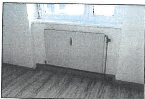
Foto Nr.: 51 – Radiatoren in Mauernische – Verrohrung in Sesselleiste eingebaut
