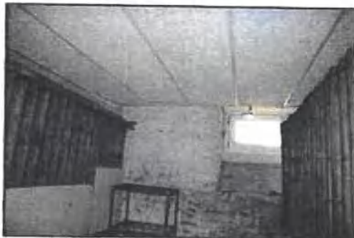
Foto Nr.: 45 – Kellerdecke wärmegeklämmt
