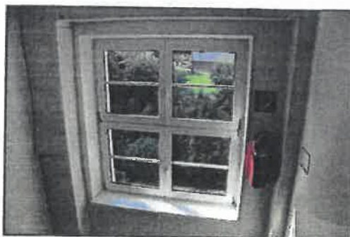
Foto Nr.: 35 - Feuerlöscher
