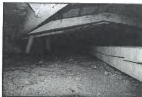
Foto Nr.: 28 – Holzdachstuhl Giebelbereich
