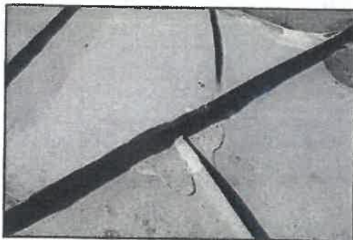
Foto Nr.: 17 – lokale Ausbesserungen Flüssigfolie
