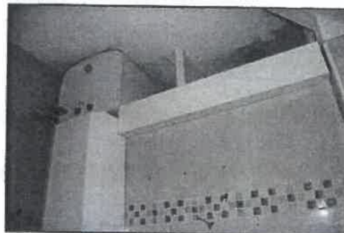
Foto Nr.: 54 – Sanitäreinheit Boiler Deckennische eingebaut
