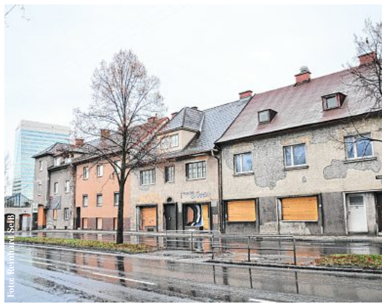
Die Häuser müssen der Autobahn weichen. Links: der Terminal Tower.
