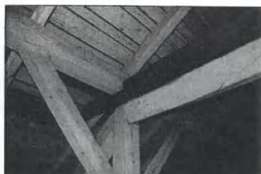
Foto Nr.: 28 zusätzliche statische Auswechslung Zangenpaar
