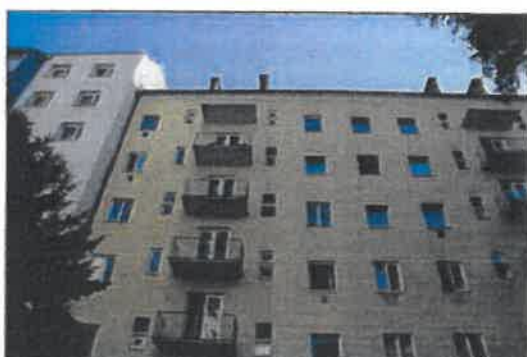
Foto Nr.: 7 Fassade hofseitig
