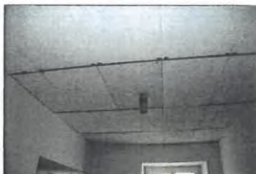
Foto Nr.: 46 Kellerdeckendämmung
