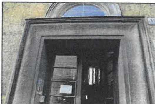
Foto Nr.: 31 Zugang straßenseitig
