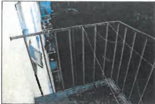
Foto Nr.: 13 Balkongeländer
