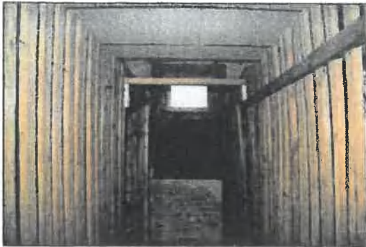
Foto Nr.: 49 Kellerabteile Holz
