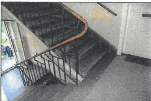
Foto Nr.: 35 Stiegengeländer
