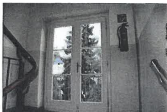
Foto Nr.: 36 Ausgang Balkon
