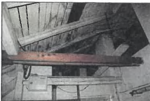
Foto Nr.: 27 zusätzliche statische Auswechslung Zangenpaar
