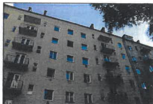
Foto Nr.: 8 Fassade hofseitig
