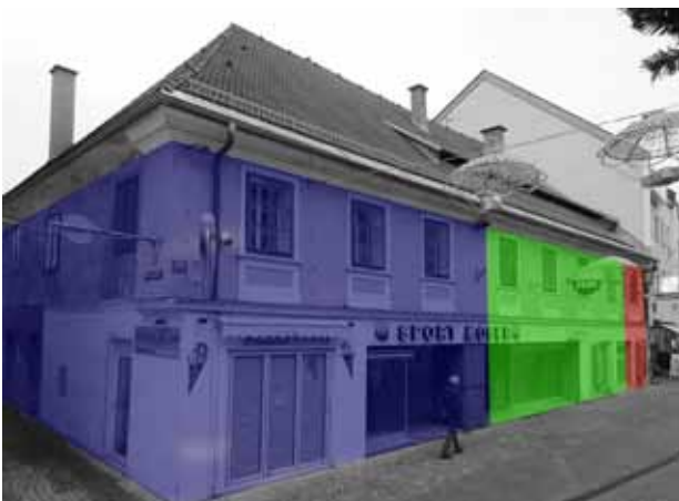
Abb. 3: Ansicht des Gebäudes St. Veit Unterer Platz 10 mit Farbrunterlegungen der einzelnen Bauphasen. Im Uhrzeigersinn: Blau-Kernbau, grün-1. Erweiterung, roter Streifen-Stadtmauer, © Robert Kuttig
