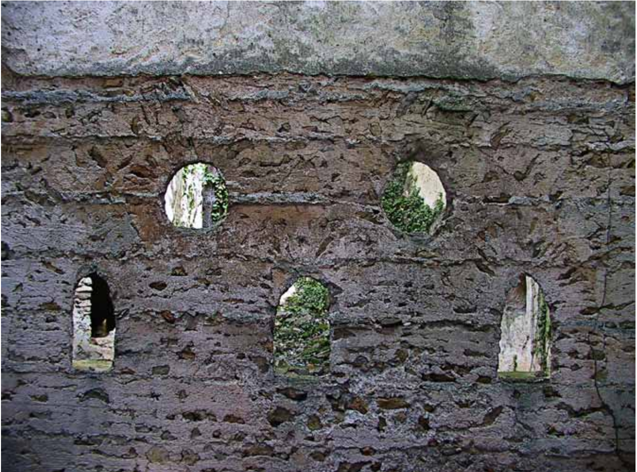
Abb.:1 Burgruine Thernberg, sehr gut erhaltene Mörtelnegative der ummauerten heute verlorenen Holzstube, 1. H. 14. Jh., Zustand 2003, © Ronald Woldron
