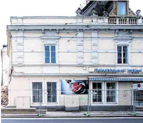
2022 abgerissen: das Hackl-Haus in der Mozartstraße (vowe)
